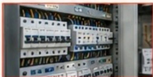
Remplacement et raccordement
