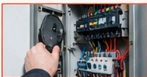
Interventions de remplacement
